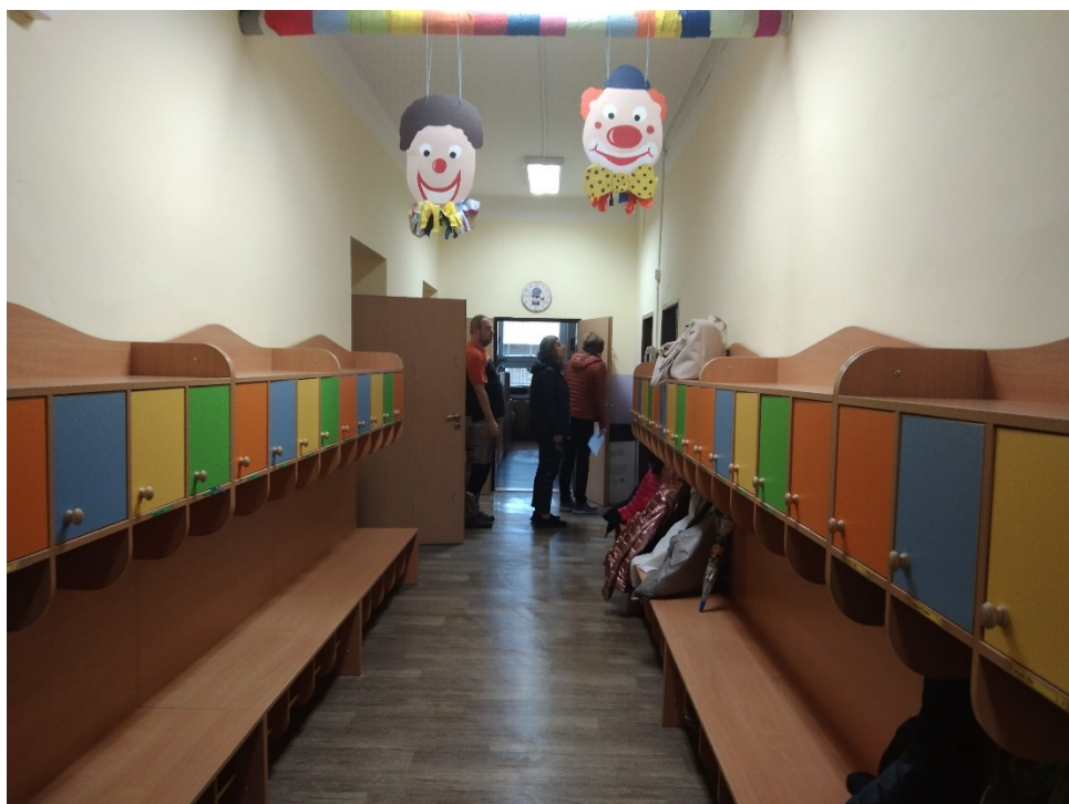
Obrázek 2 zachovat rozvody telefonu pro komunikaci s rodiči, elektroinstalaci zasekat
