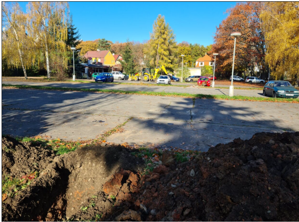
Pohled na posuzované parkoviště s kovanou sondou KS-2, v pozadí traktorbagr a KS-1
