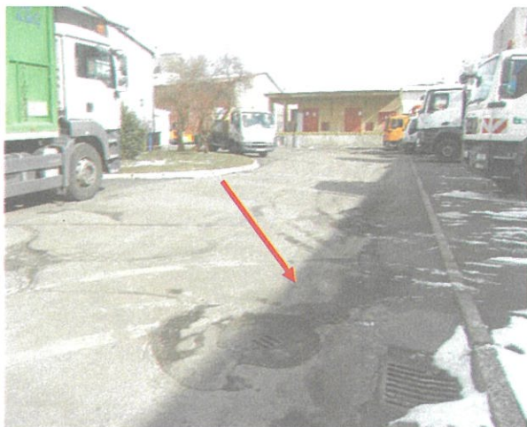
(vlevo – nejnižší položené místo u budovy E a F, v záběru typické uspořádání kanalizační šachty a dešťové vpustí v rámci celého areálu v hlavní příjezdové komunikaci; vpravo – pohled mezi budovami na osazené dešťové vpustí)
