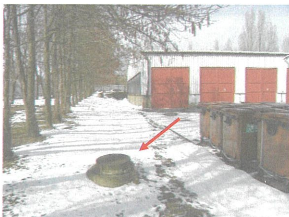
(vlevo – kanalizační šachta v zadní část areálu; vpravo – typické zaústění dešťových svodů z budov A až D do volna)
