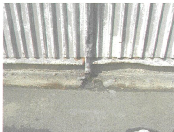
(vlevo – kanalizační šachta v zadní část areálu; vpravo – typické zaústění dešťových svodů z budov A až D do volna)
