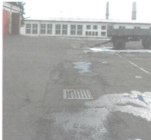
(vlevo – nejnižší položené místo u budovy E a F, v záběru typické uspořádání kanalizační šachty a dešťové vpustí v rámci celého areálu v hlavní příjezdové komunikaci; vpravo – pohled mezi budovami na osazené dešťové vpustí)
