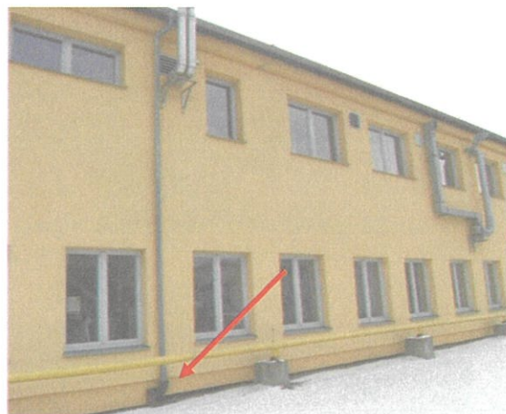
(vlevo – betonový žlábek včetně dešťové vpustí u budovy Restamo; vpravo – dešťový svod z budovy SOŠ a OA Ústeckého kraje sveden přes lapač splavenin do areálové kanalizace)
