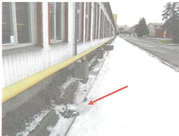
(vlevo – betonový žlábek včetně dešťové vpustí u budovy Restamo; vpravo – dešťový svod z budovy SOŠ a OA Ústeckého kraje sveden přes lapač splavenin do areálové kanalizace)
