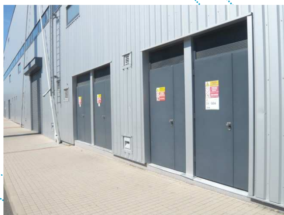
Foto 10 – Zimní stadion trafostanice
