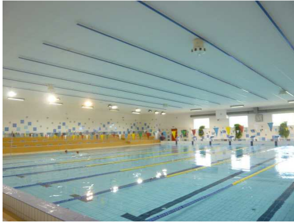
Foto 1 – Hlavní bazén v Aquasvětu
