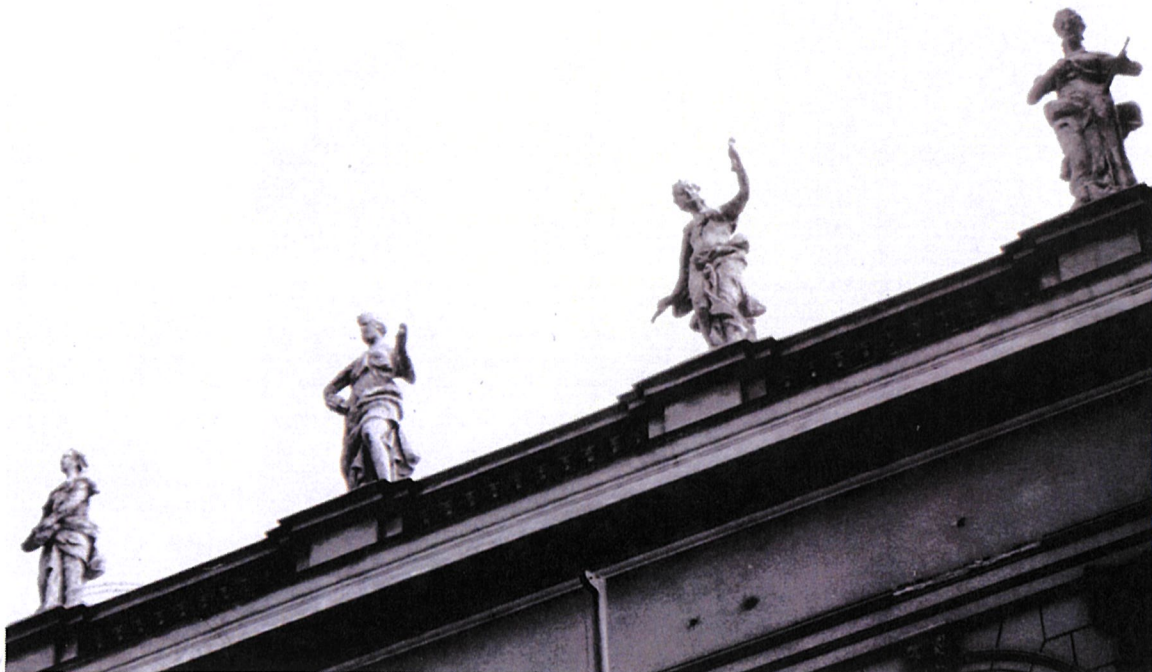
Sochy byly umístěny na širších dvakrát odstupňovaných pilířích mezi užšími zdmi atiky na hlavním průčelí – pilíře jsou zachovány a nenesou stopy poškození a jsou chráněny oplechováním
