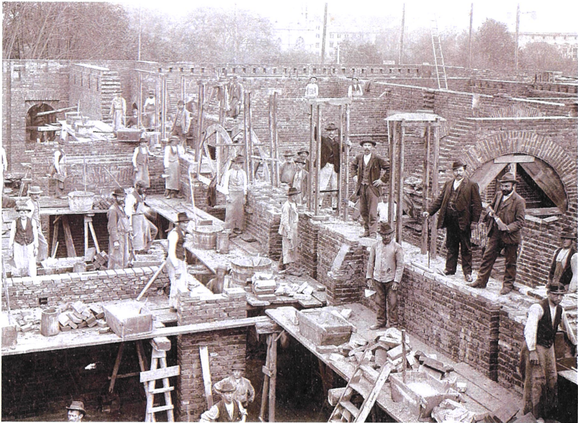
Stavba divadla – způsob zdění stěn z plných cihel – atika je patrně provedena z tohoto materiálu
