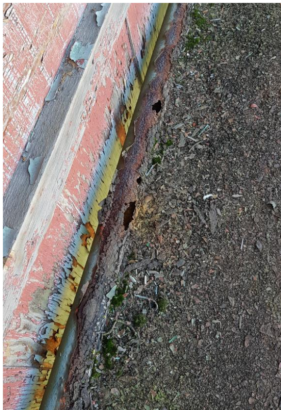
Obr. 6: 100% korozní poškození horizontální trubky, nečistoty hromadící se na pochozích plechách servisních lávek
