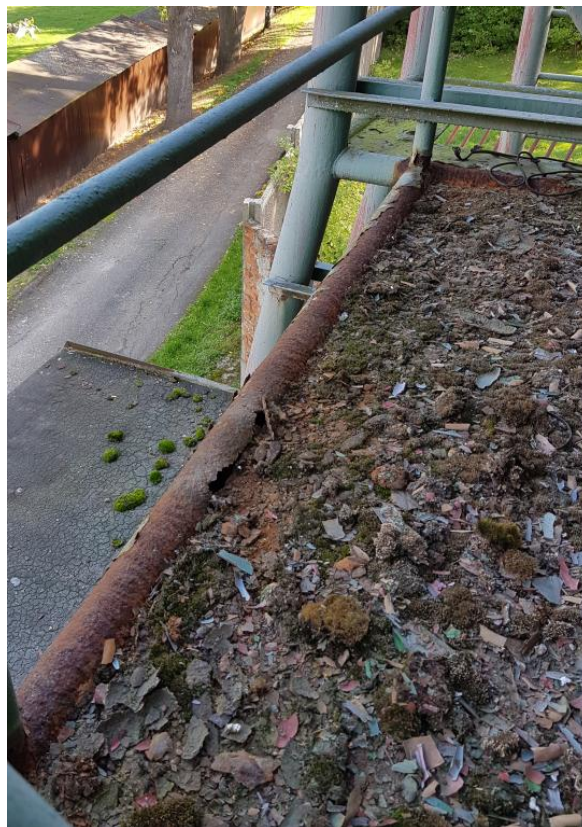
Obr. 6: 100% korozní poškození horizontální trubky, nečistoty hromadící se na pochozích plechách servisních lávek
