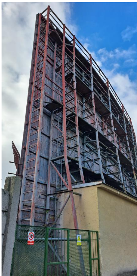
Obr. 2: Ocelová konstrukce plátna
