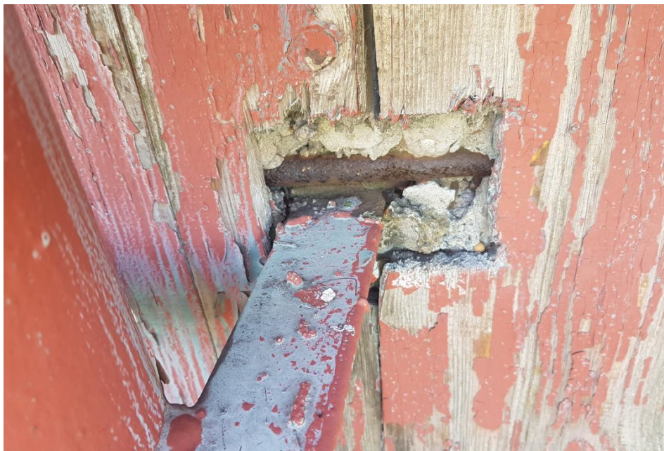
Obr. 14: Kotvení NOK do skořepiny, která je pravděpodobně ze železobetonu (není možná kontrola) s dřevěným obložením
