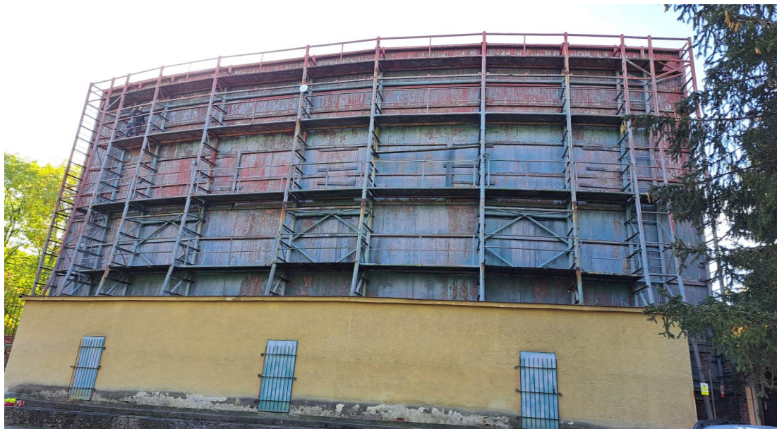
Obr. 1: Ocelová konstrukce plátna
