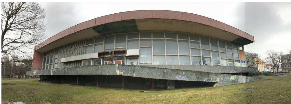
pohled z fotbalového hřiště
